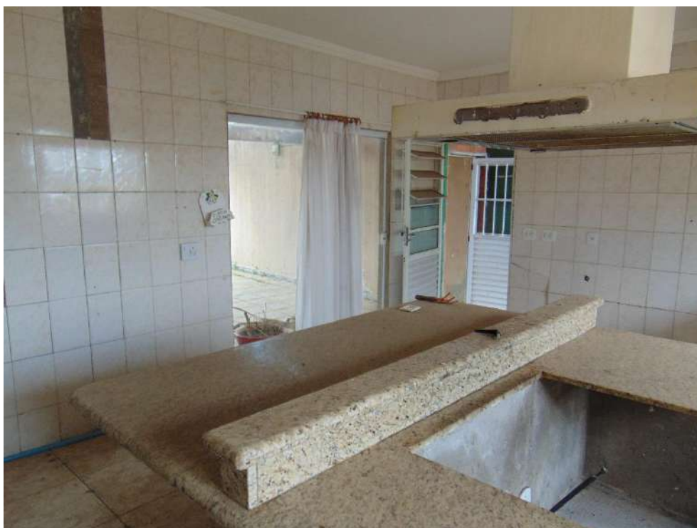
Figura 25 Detalhe de Vista Externa da Cozinha
