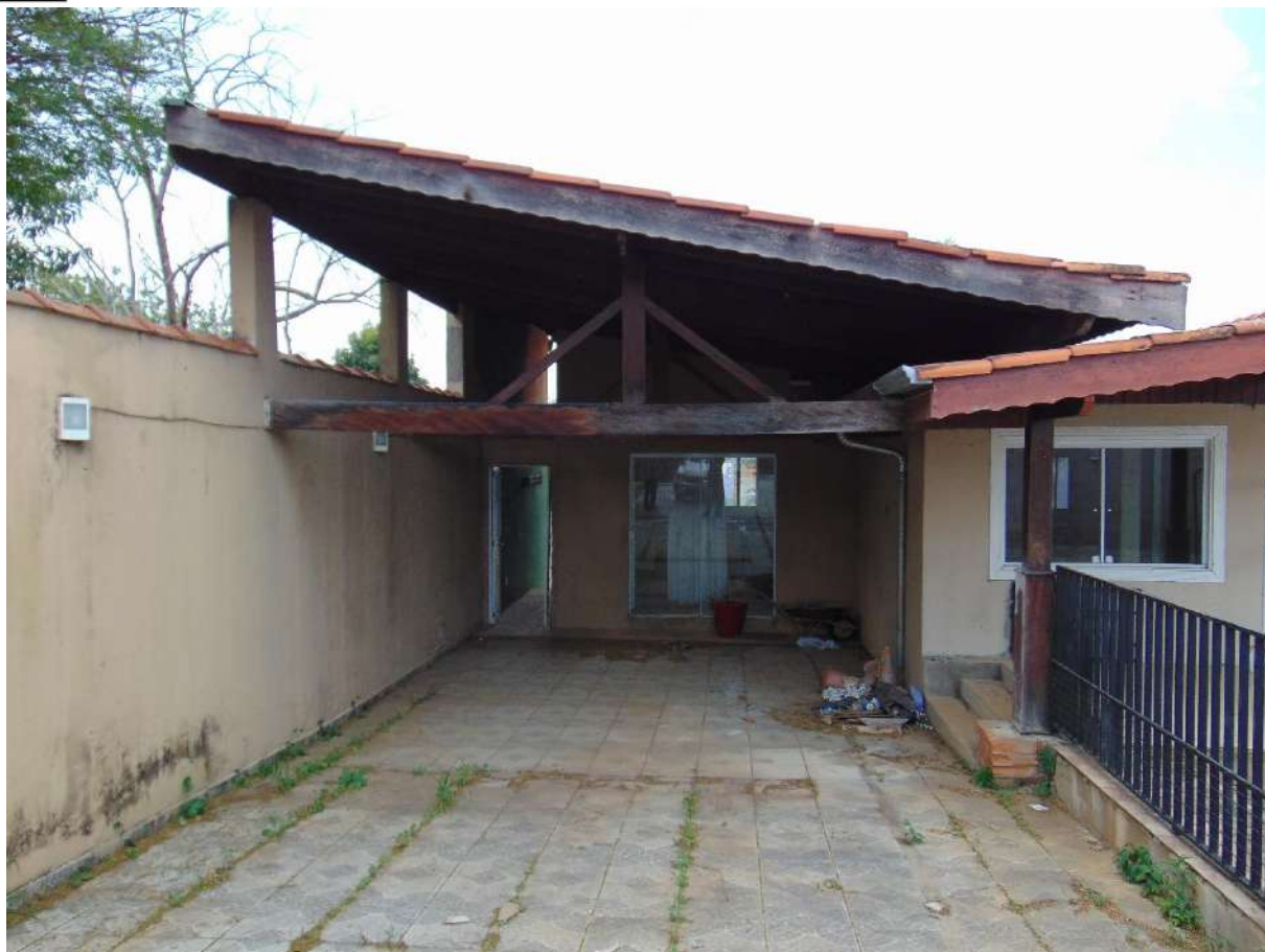
Figura 2 Fachada Interna do Imóvel, área de garagem
