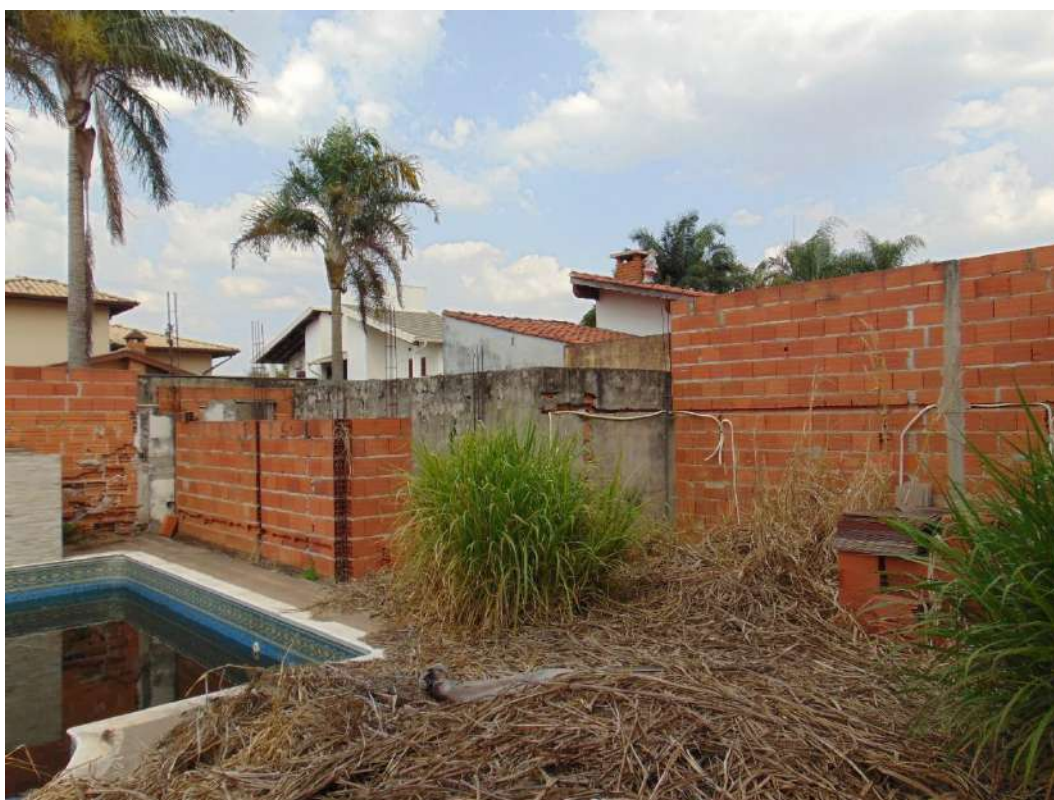
Figura 15 Detalhe de obras inacabadas aos fundos dos canis
