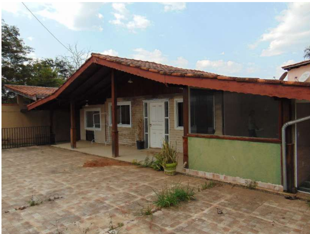
Figura 8 Fachada interna do imóvel
