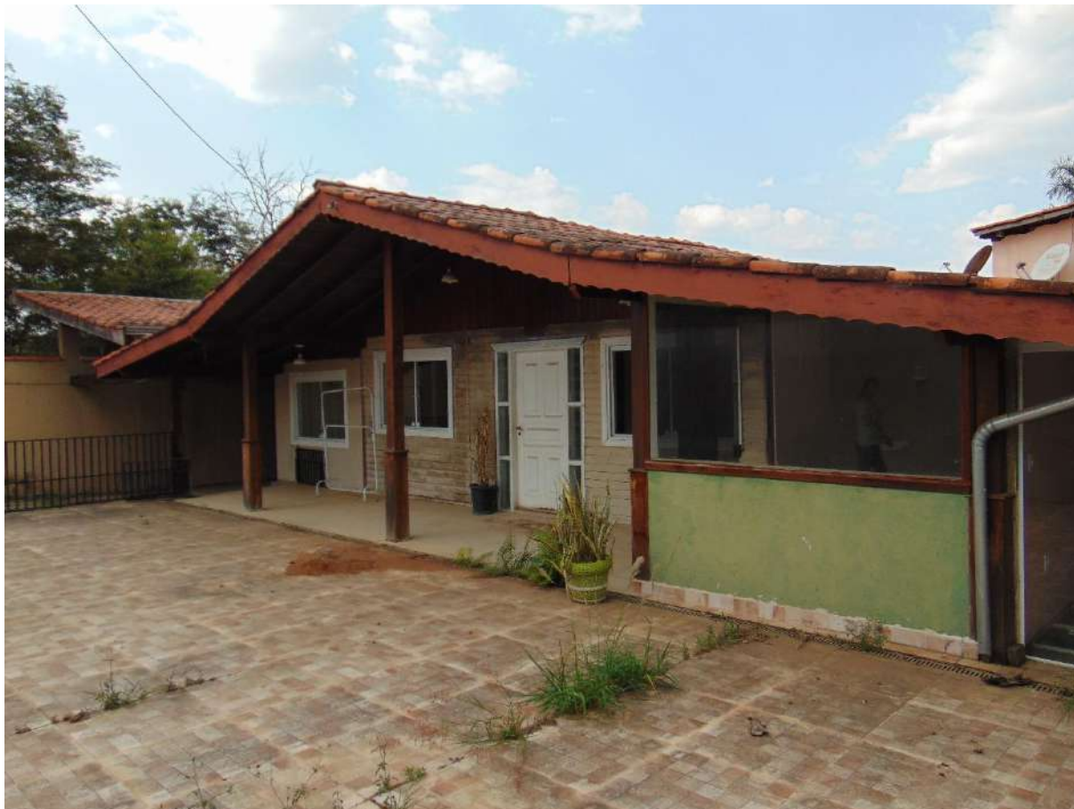
Figura 1 Fachada do imóvel, vista do interior do terreno
