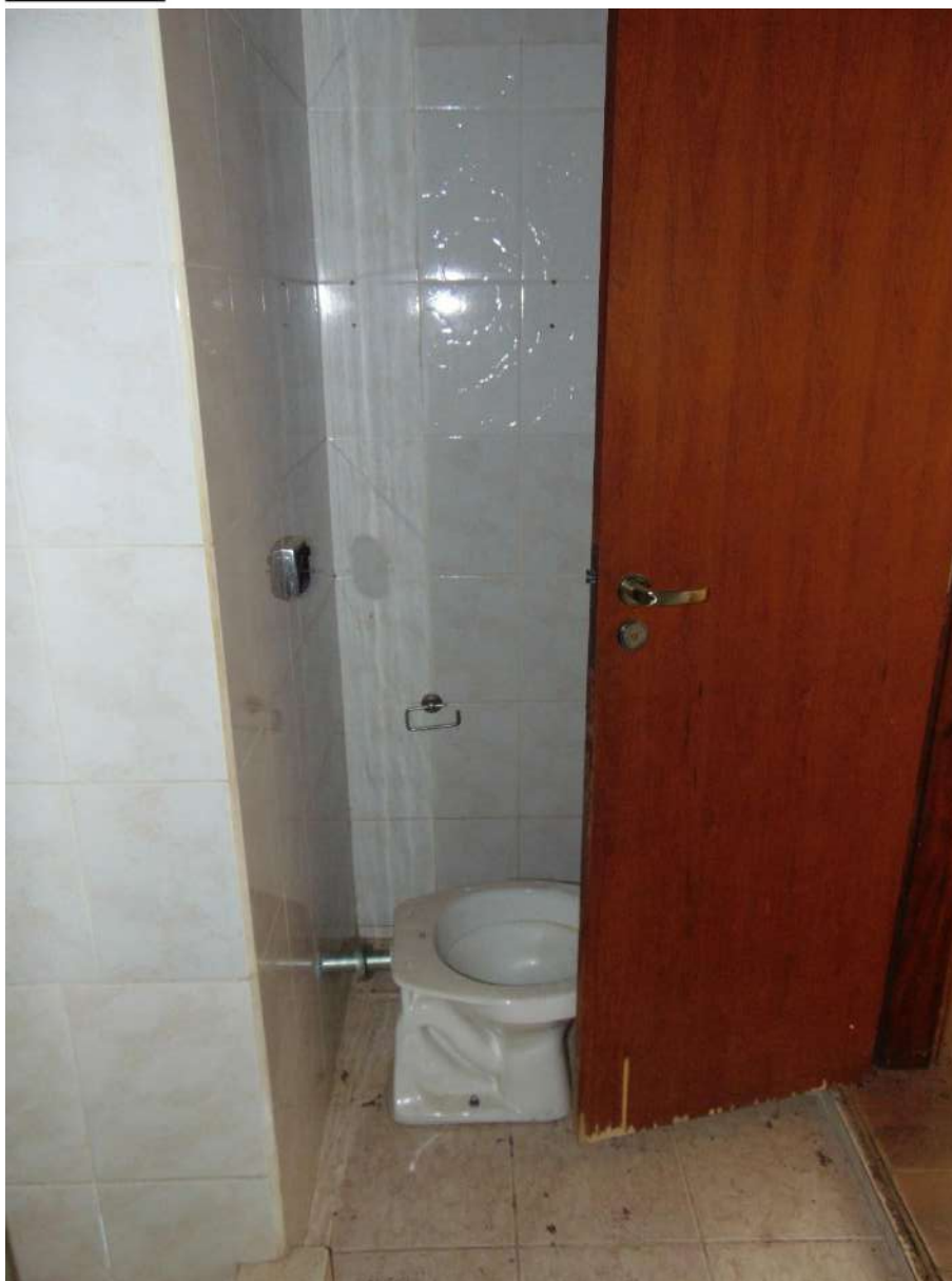
Figura 41 Detalhe da porta e vaso do banheiro da suíte
