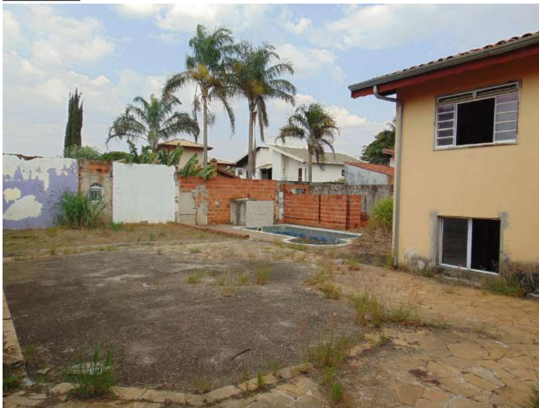
Figura 10 Vista da Área de Lazer Externa, muitas vegetações crescendo do piso, pintura completamente desgastada, e obra inacabada
