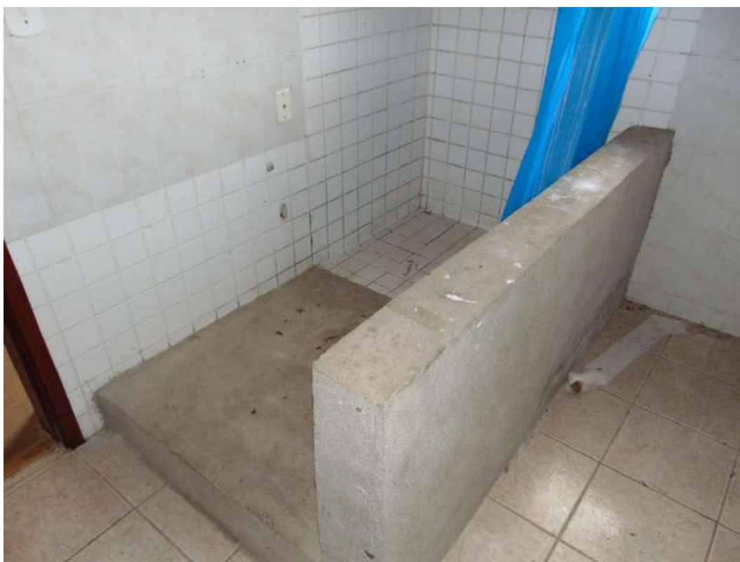
Figura 44 Detalhe box inacabado
