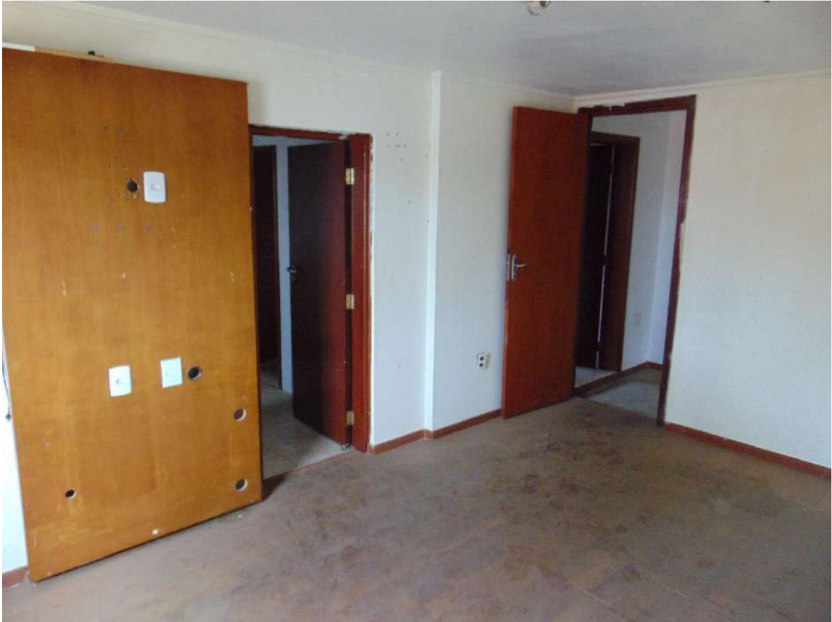
Figura 42 Vista Interna da Suíte 2
