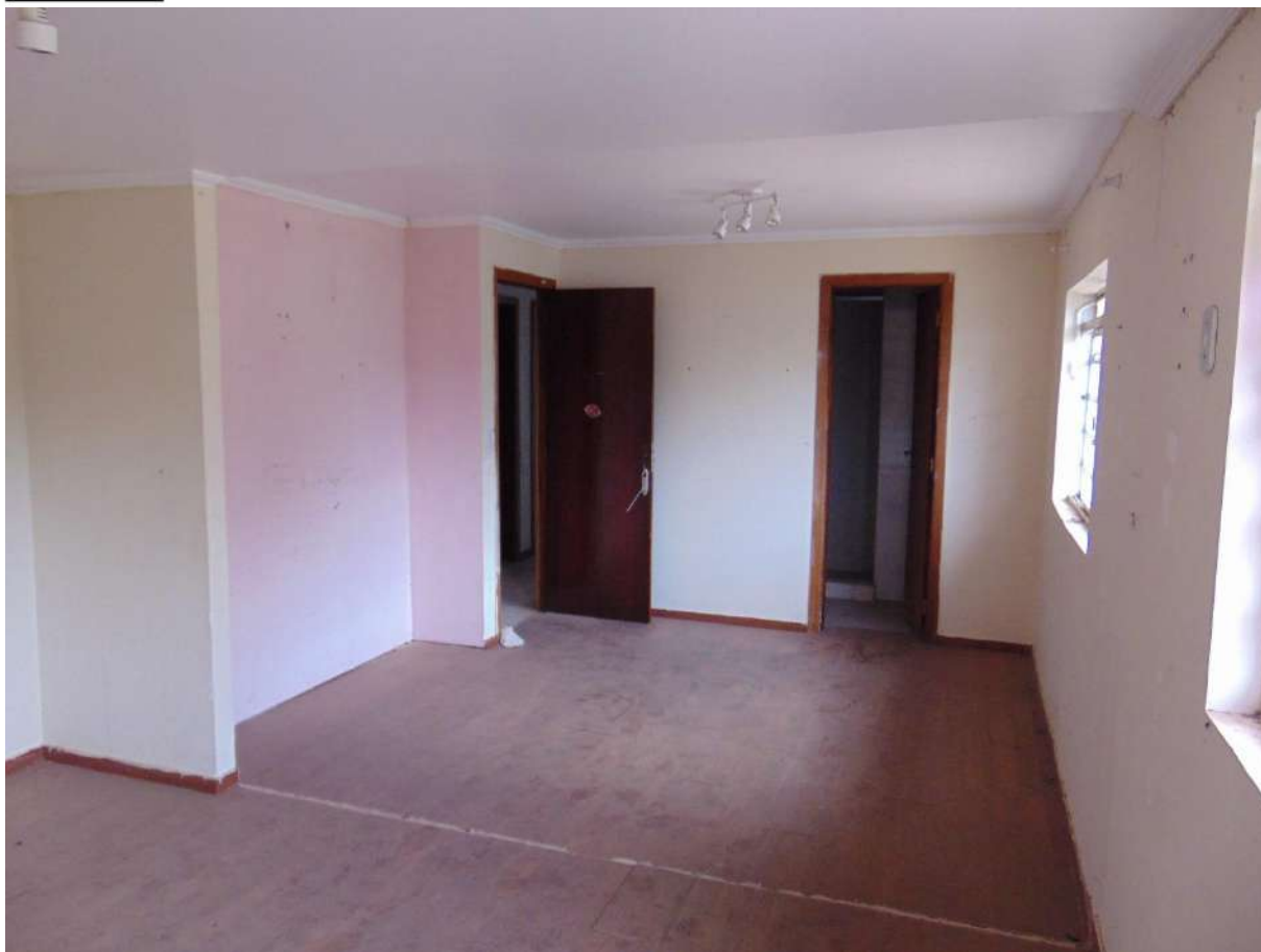
Figura 39 Vista Interna da suíte 1
